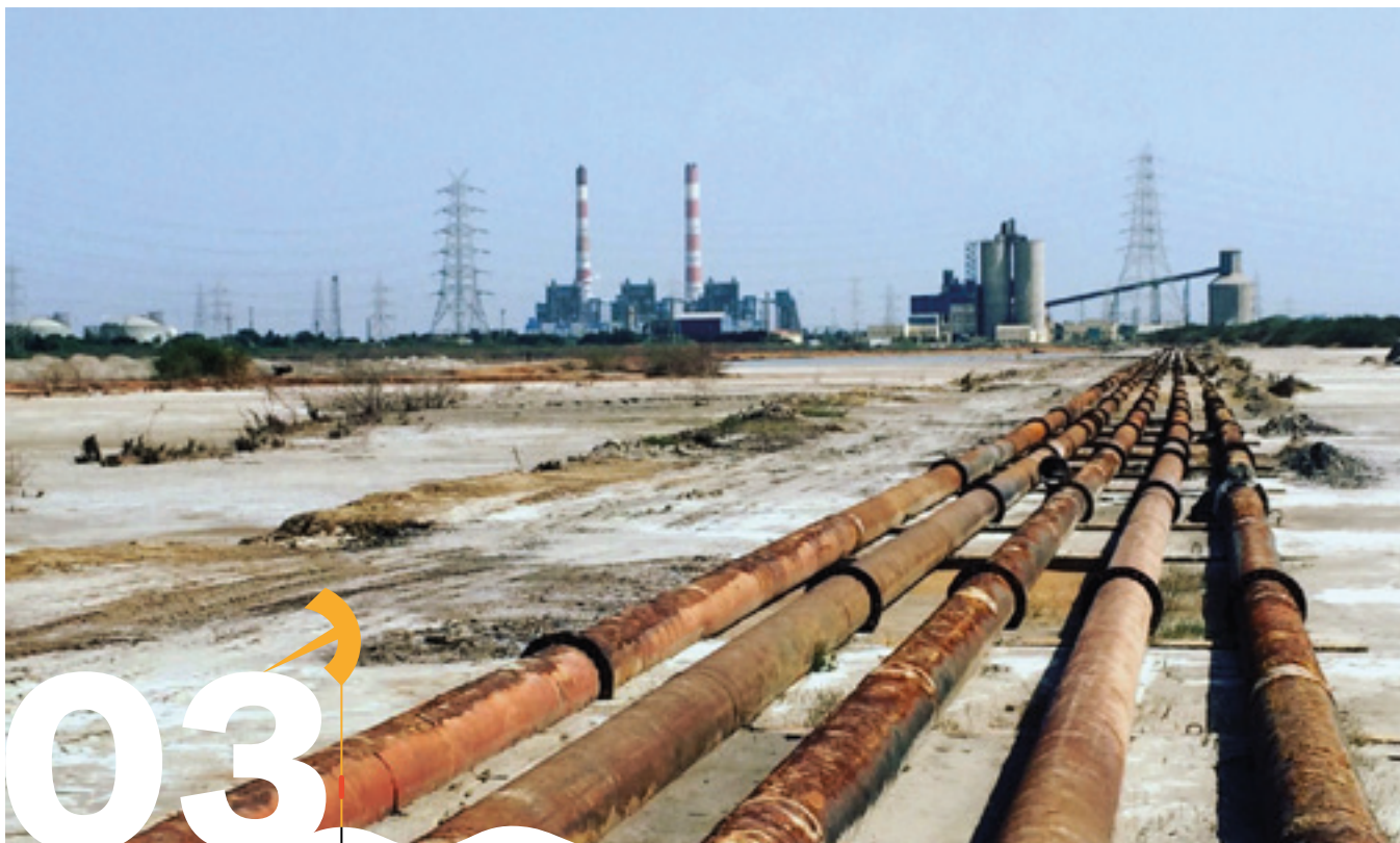
Pipelines transportant des boues de cendres de charbon provenant de centrales électriques à Ennore, au nord de Chennai, en Inde
